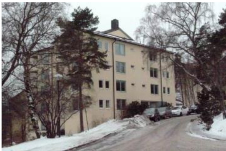
Fasaden mot Lidköpingsvägen.
