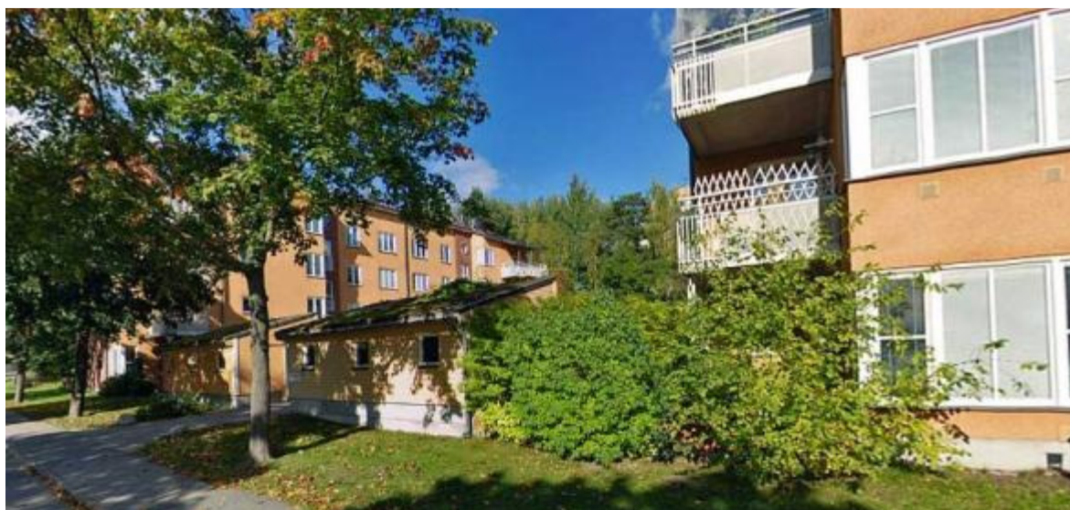
Husens gavlar vetter mot Ystadvägen. Lövträd ger sommarskugga mot de södervända gavlarna, men solvärme in i lägenheterna på vintern, vilket minskar uppvärmningsbehovet.
