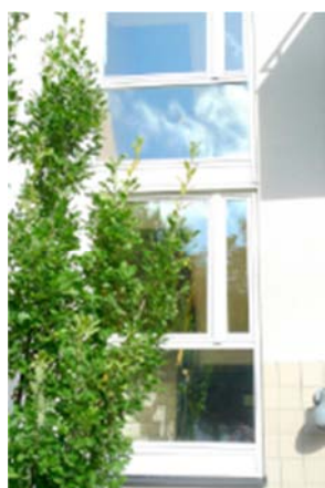
Trapphus i kv. Tuschpennan 1
