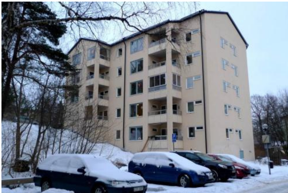
Huset sett från sydväst
