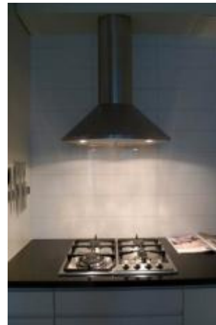
Gasspisen har kåpa och köksfläkten kan forcera flödet till 40 l/s för att säkerställa att inte kvävdioxider från gasspisen kan nå rumsluften.
