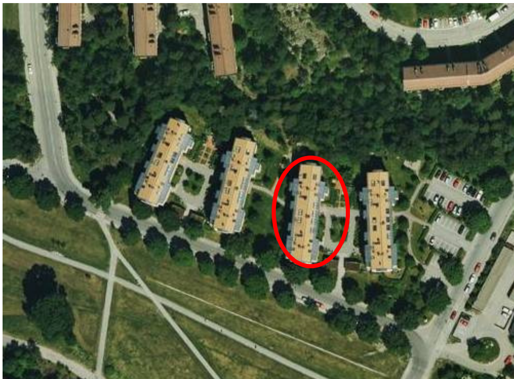
Kv. Tjockan består av fyra femvånings lamellhus. Portiker ger genomblick och en gångväg som binder samman gårdarna. Inringat är aktuellt hus, Ystadvägen 121-123.
