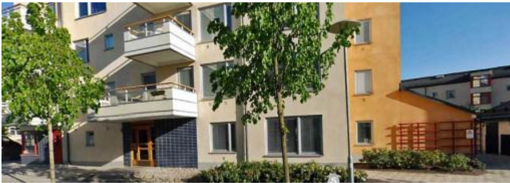
Husets norra fasad, sedd från Koldinggatan.
