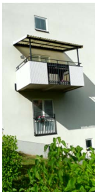
En utskjutande balkong artikulerar östra gaveln
