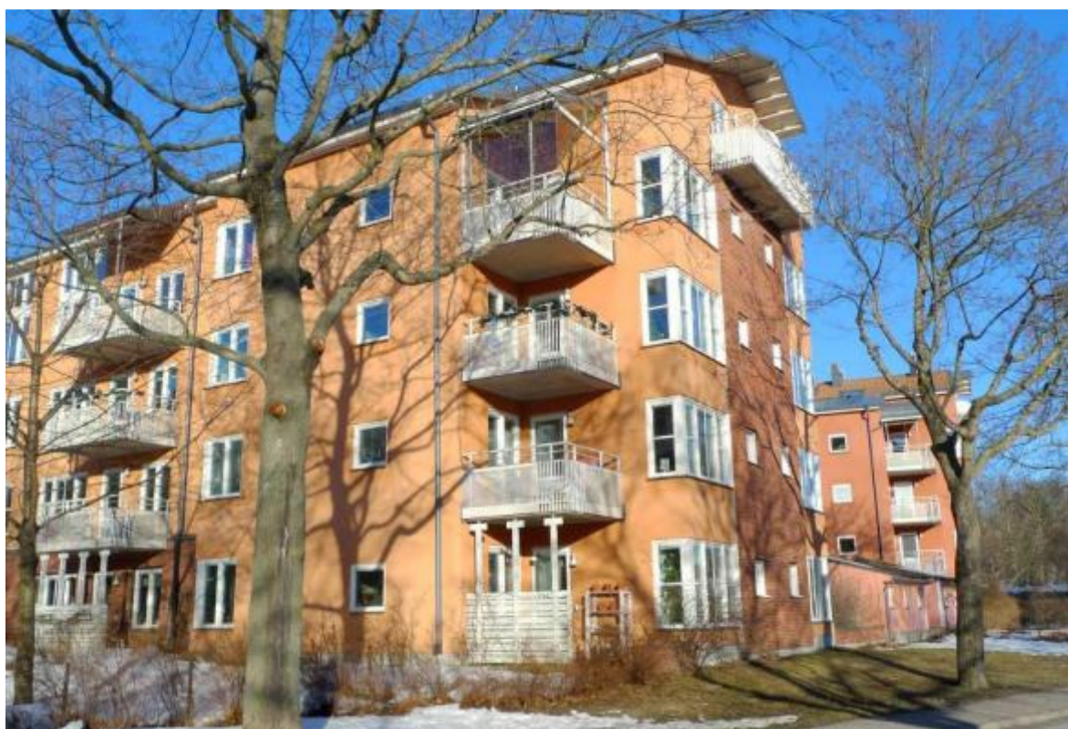
Huset Ystadvägen 121-123, sett från väster.
